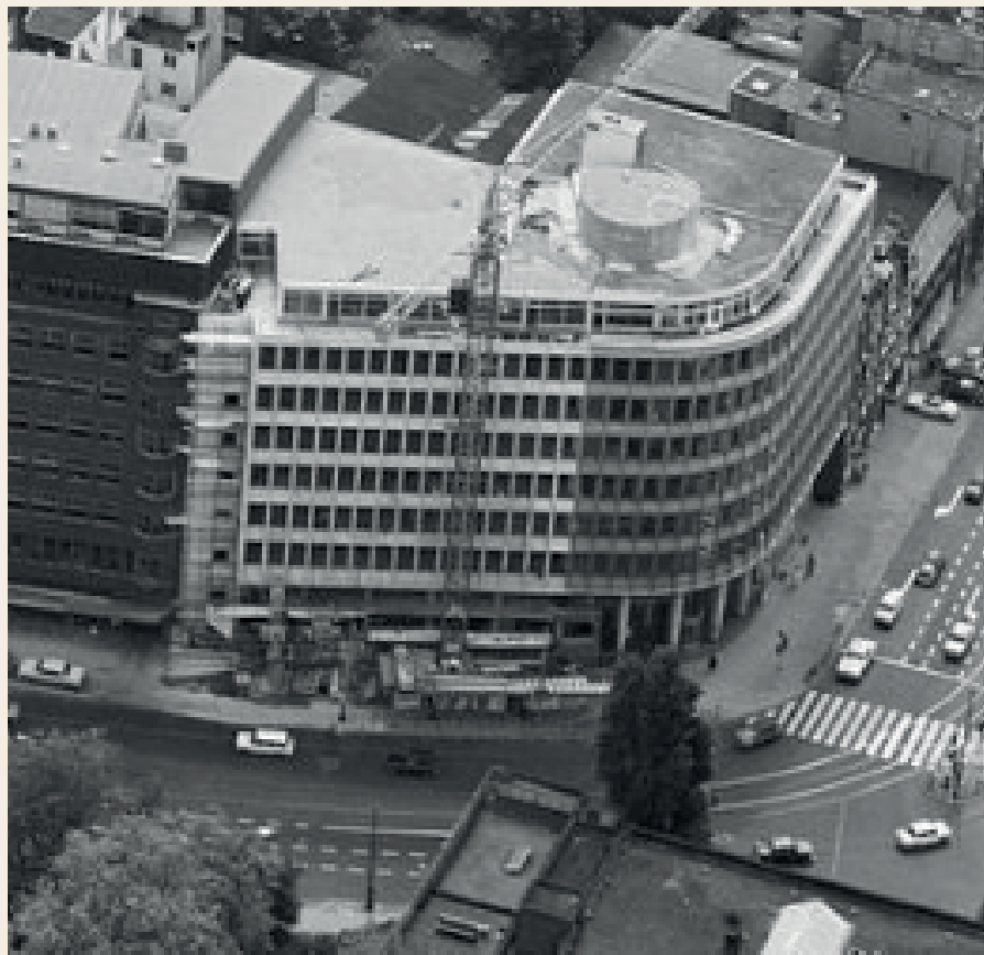
Aurora fase 2 in aanbouw.
